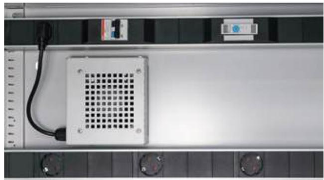
Temperaturgesteuerter Lüfter und Zentrale Masterleiste beim Comfort-Schrank
