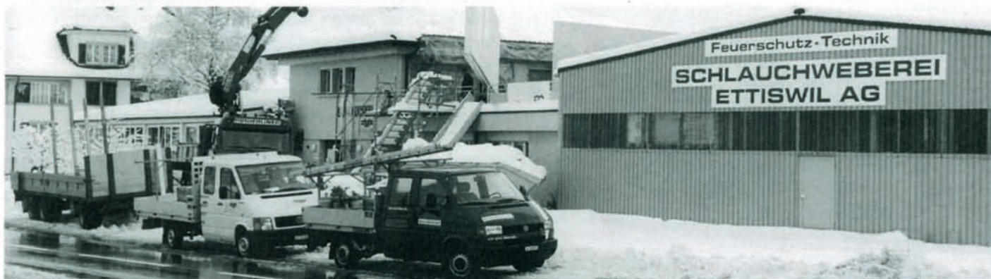
Der Umbau schreitet voran (Bild vom 8. Februar 1999)
