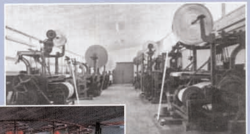
Flachwebstühle aus der Produktions- anlage 1961
