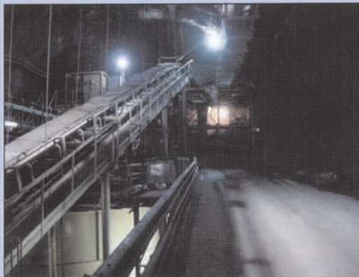
Das abgebaute Felsmaterial wird per Förderband abtransportiert...
